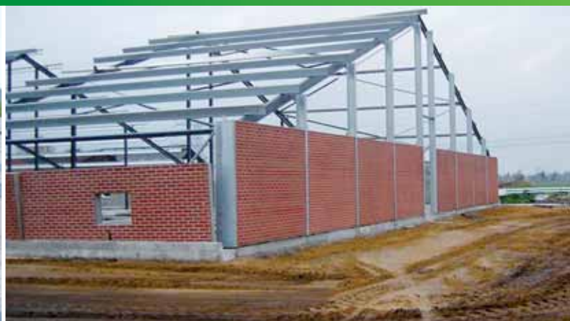
Met stalen gordingen is een grotere overspanning mogelijk. De prefab elementen hebben een hoge isolatiewaarde en maken het mogelijk om snel te bouwen.
